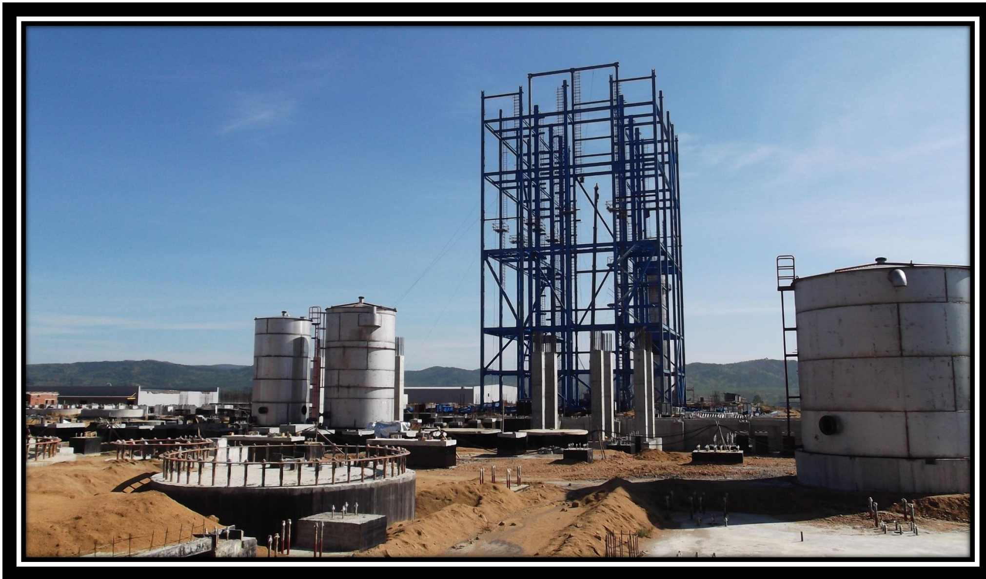
Монтаж оборудования 1 30.06.18 г.
